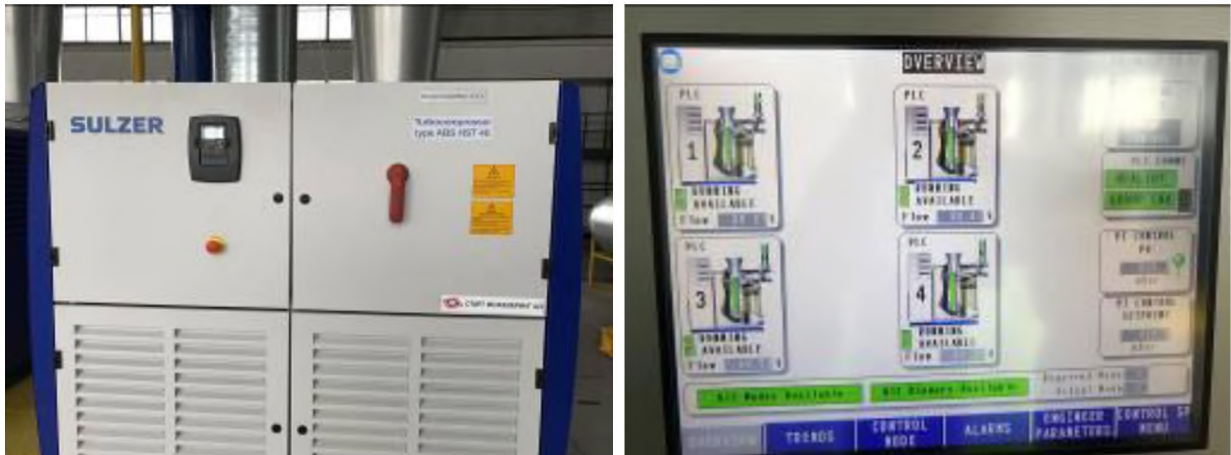
Фиг. 5.2.1.2 Инсталирани компресори в СПСОВ „Кубратово“
