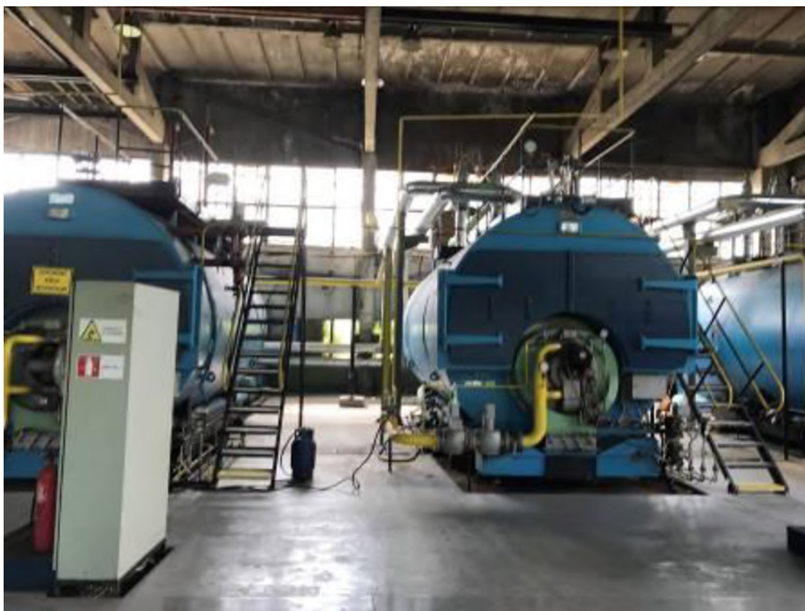
Фигура 4.2.2.3 Реализирани 3 бр. водогрейни котли тип ПКМ 12
