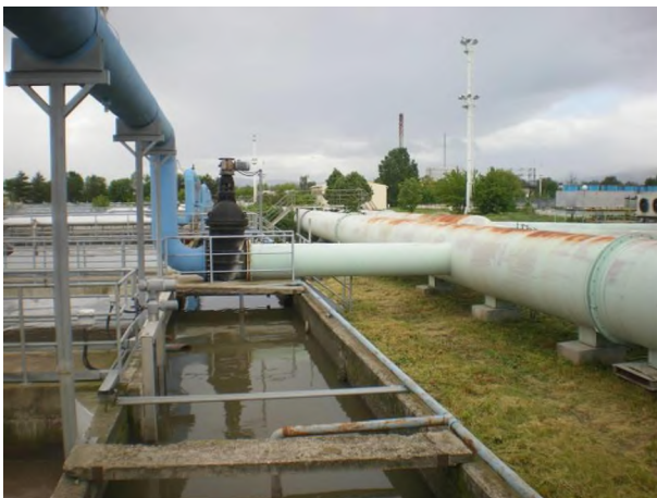
Фиг. 5.2.1.4 Тръбна система за пренос и разпределение на сгъстения въздух
